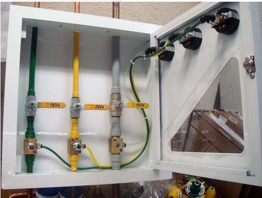
Caixa Seccionadora 2
