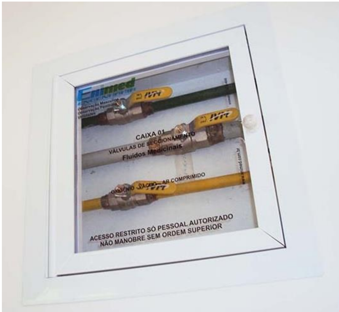
Caixa Seccionadora 1
